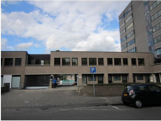
Onderdoorgang onder het annexum naar het parkeerterrein van de Runmolen
